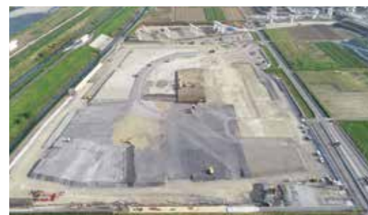
▲ 4月 擁壁工事等の様子
