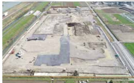
▲ 3月 擁壁工事等の様子
