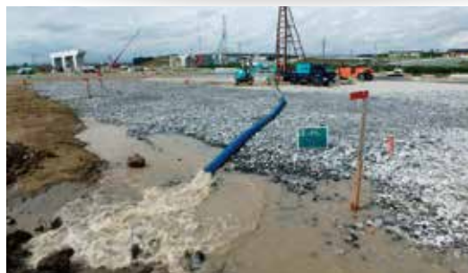
▲ 井戸掘削の様子(写真①)
